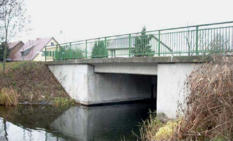
Foto 1: Brücke L 21: Maßnahme: Ersatz durch eine Klappbrücke
