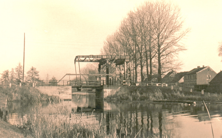
Foto 1.1: Liebenwalde, ehemalige Klappbrücke L21, Blick Richtung Westen
